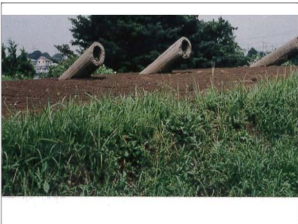
またこれは花野井に確認されている、燃料庫の上に作られた煙突状の空気穴です。
