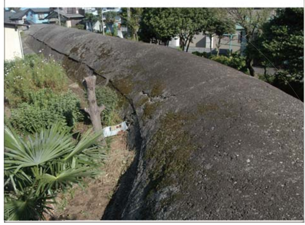
また別の燃料庫の掩体がこちらです。民家の中に50m近く存在します。燃料庫はこのように作られています。この燃料庫は40数年前に花野井の東急ビレジが作られる前に出入口を塞いでおり、現在ではどうなっているかわからなくなっていましたので、この先できたら内部の調査したいと思っています。以上で卓話を終わらせて頂きます。
