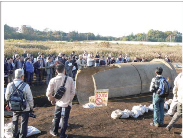
そして現在発掘された当時の施設ですが、これはヒューム管と言って、秋水の燃料輸送に使われたものです。
